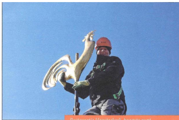
Restauratie kloosterkerk, hoogste punt
